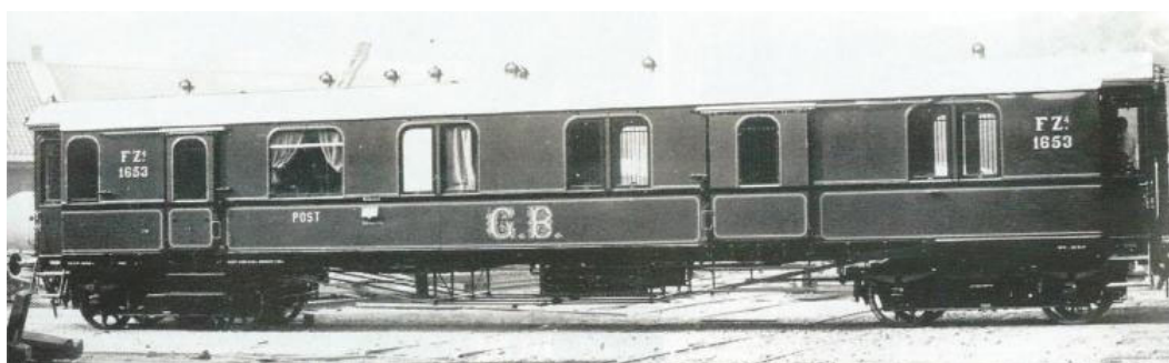
GB-Gepäckwagen Typ FZ4 no 1653, gebaut von der Firma Wagenfabrik in Rastatt, Deutschland
