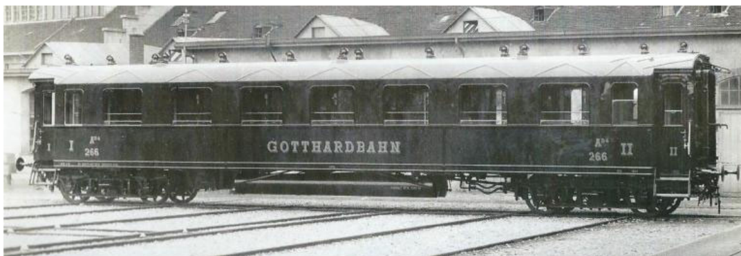
GB (Gotthardbahn) AB4 no 266, etwas spätere Ausführung (Gangseite) mit Schriftzug "Gotthardbahn" aber immer noch blau Ausführung und mit der überaus gefährlichen Gasbeleuchtung (Gastank unter dem Wagenboden)
